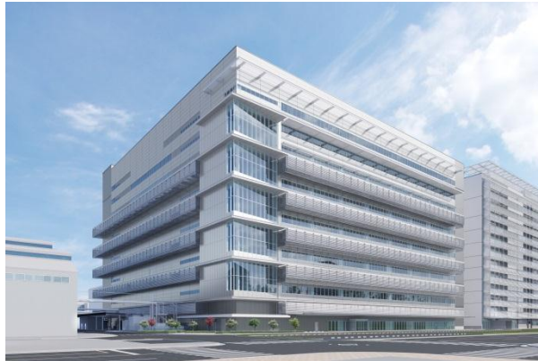
位于总公司工厂内,正在建设的氢燃料电池堆生产厂房
